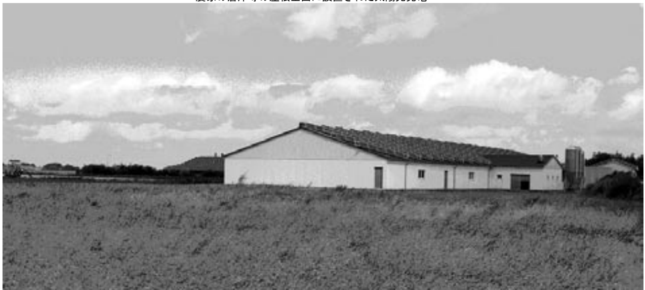
農家の倉庫等の屋根全面に設置された太陽光発電
